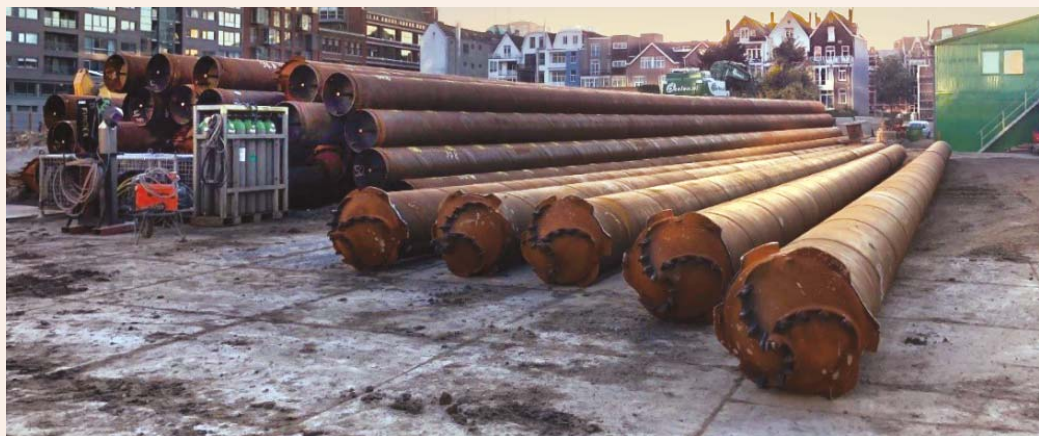
Figuur 2 – Verschillende paalsecties, (onder secties liggen rechts, boven secties liggen links)
