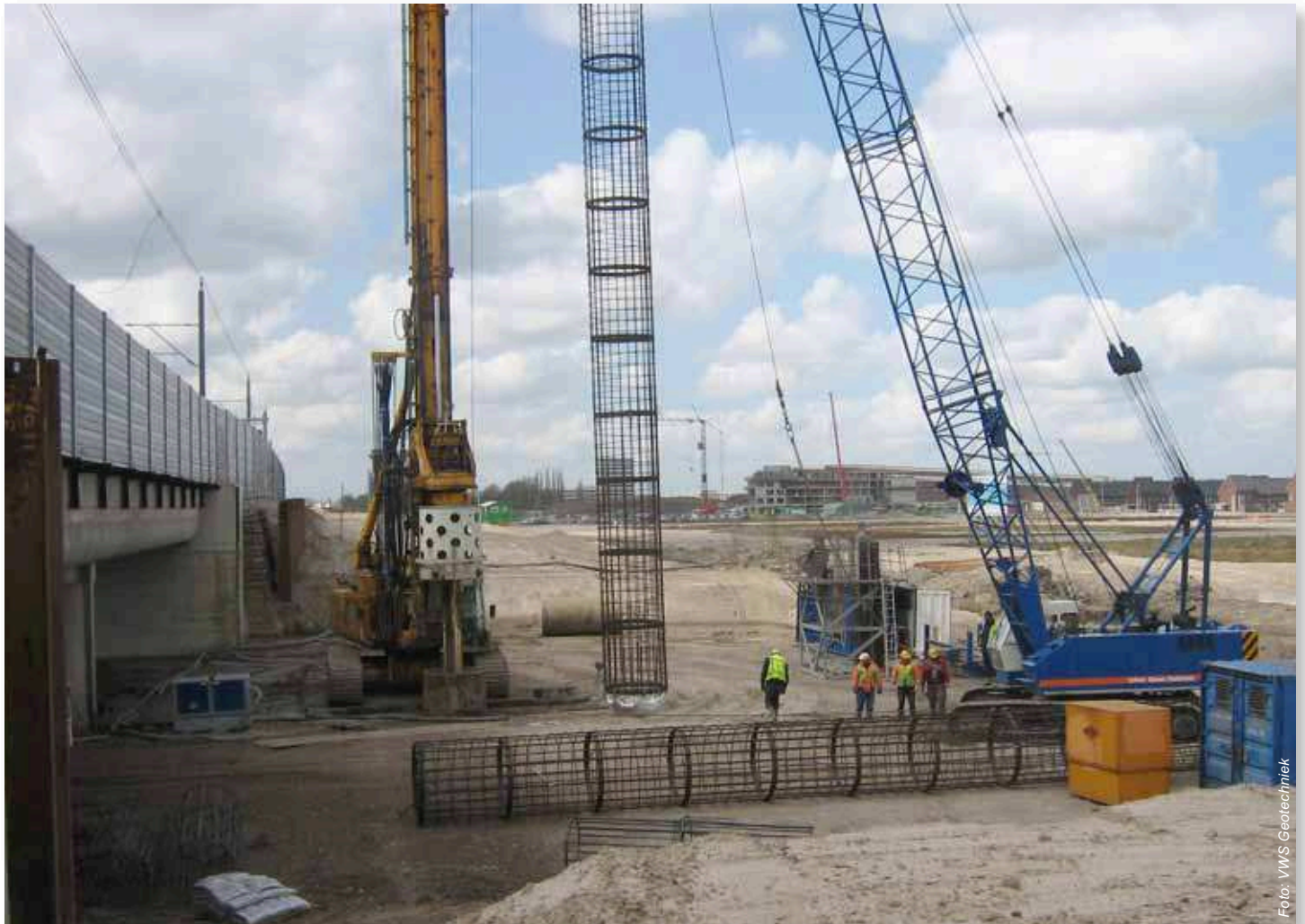
Uitvoering casing-boorpaal door Volker Staal en Funderingen.
