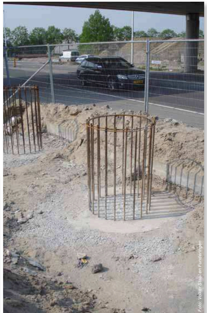
Casing-boorpaal gereed voor het plaatsen van de kolom.
