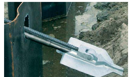
Figuur 4 Klapanker
