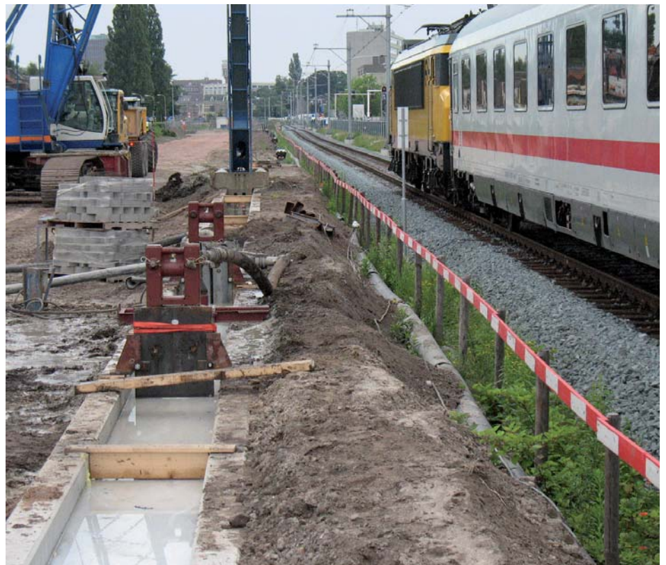
Figuur 10 Werk in uitvoering (foto Volker Staal en Funderingen).
