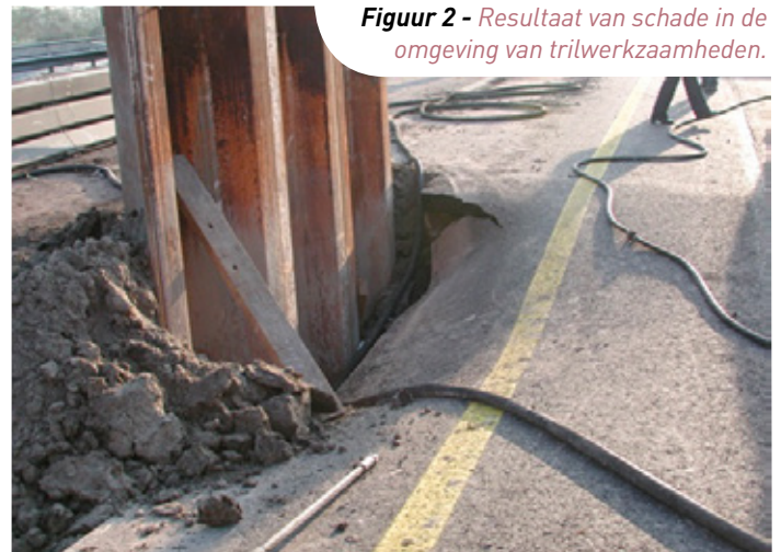
Figuur 1 - Resultaat van een slecht hei- of trilbare damwand.
