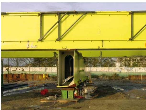
Uitvoeren proefbelasting met reactieframe.
