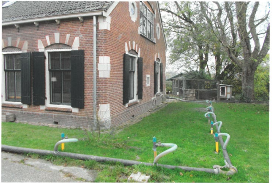
Retourbemaling om zettingen door grondwaterstandverlaging te voorkomen.
