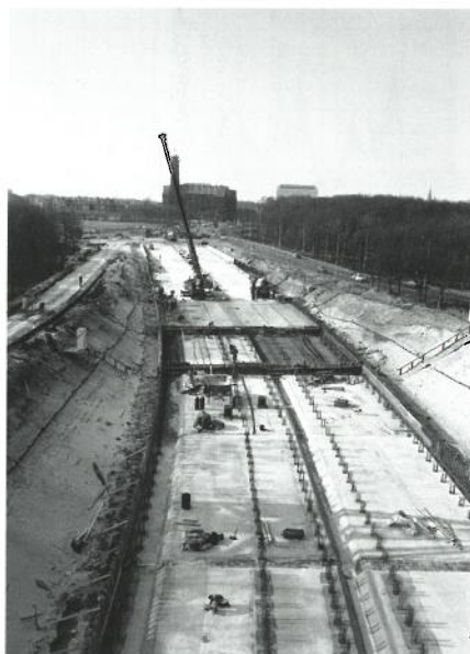
Aanleg A12 in 1973.
