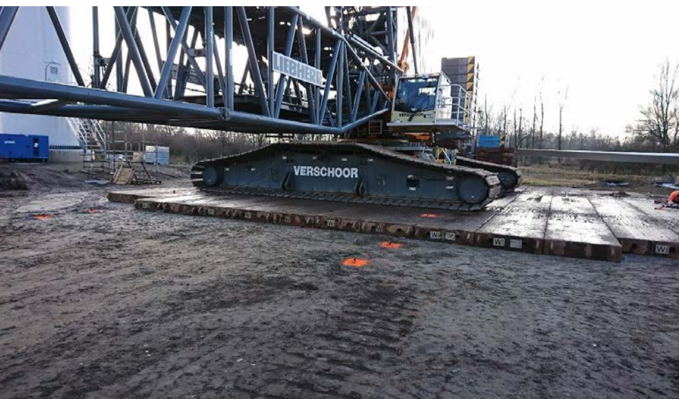
Uitvoering van de metingen tijdens het ophijzen van de kraangiek.
